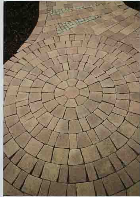
Auf saubere Ausführung der Pflasterungen legt der oberfränkische Betrieb großen Wert.
